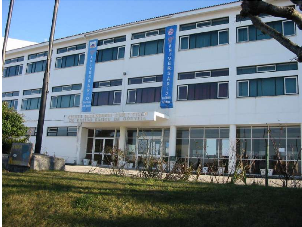
Figura 4. Escola Sede do Agrupamento de Escolas de Gouveia Fonte: http://esgouveia.pt
